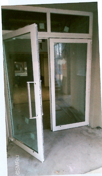
Une porte SMFeu posée au CHU de Bordeaux par l'entreprise Labastère.
